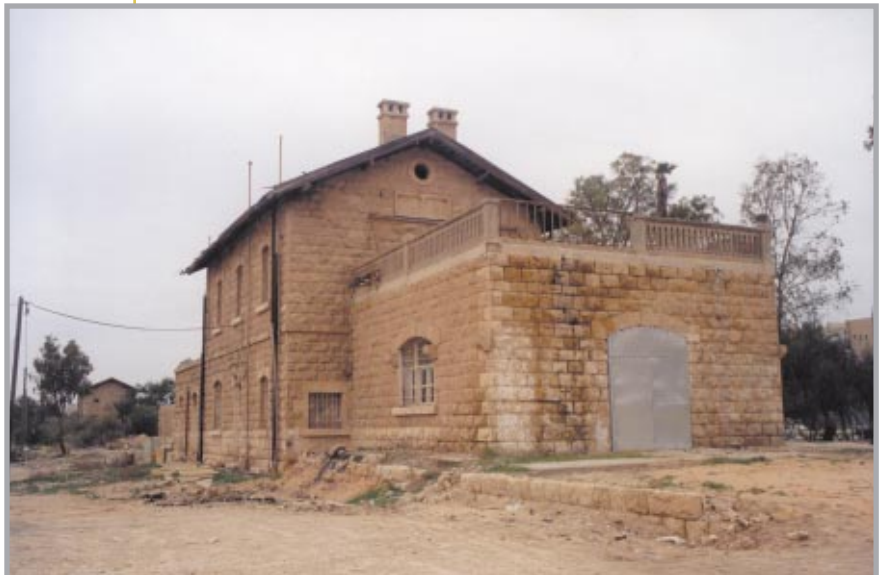
תחנת הרכבת הטורקית בבאר שבע
